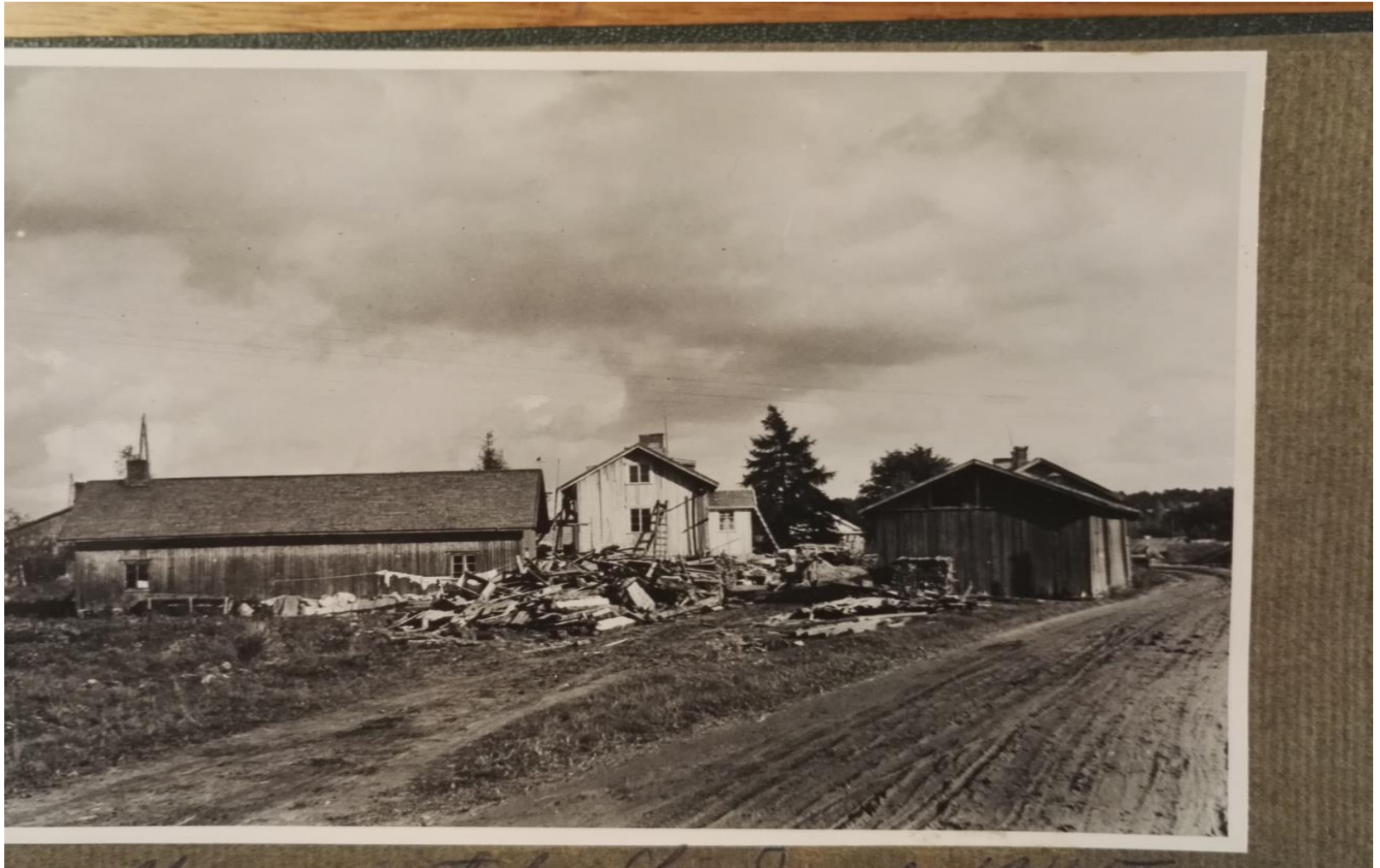
Mannin tilan rakennuksia Liedossa 1945. Tilan maille perustettiin Liedon taimisto.
