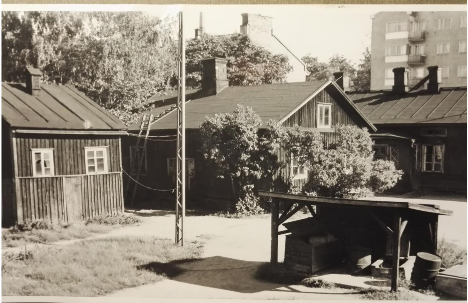
Turku Läntinenkatu 17 tontti ennen Hankkijan kiinteistön rakentamista.
